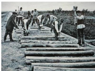
Рис 2.2 Процесс укладки шпал
