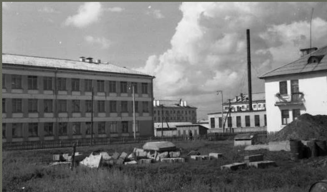
Строительство нового здания школы. Улица Шевченко, 1.
