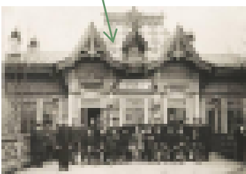
Здание вокзала Вокзал станции Тайшет
