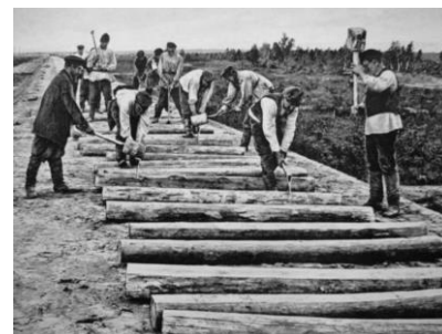
Рис 2. Процесс укладки шпал
